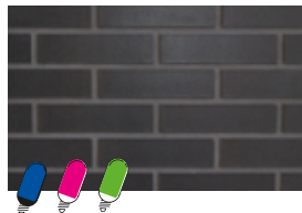
elewacja – klinkier graitowy
